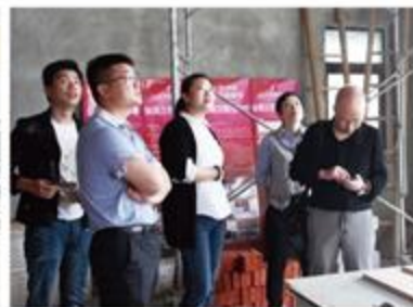
参观山水在建工地
